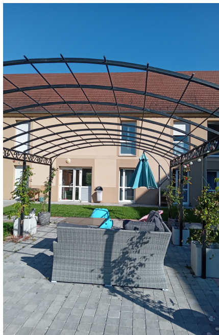
Aménagement de la terrasse Les Résidences d'Halatte 12 877,15 €
